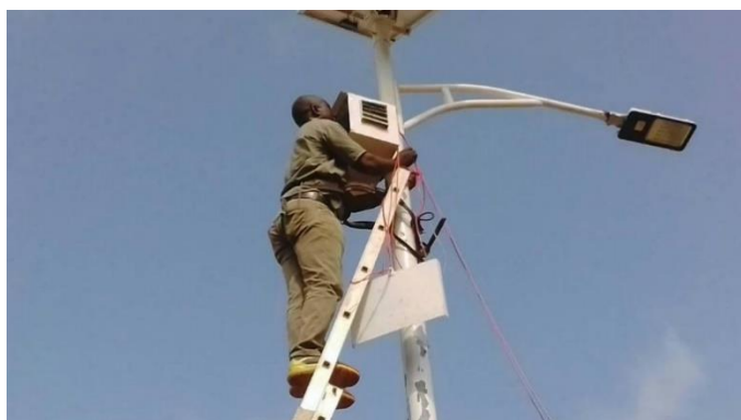
Instalación de paneles solares
