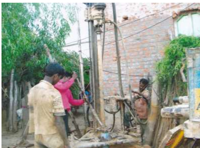
CONSTRUCCIÓN DEL POZO EN ALLIPALLI
